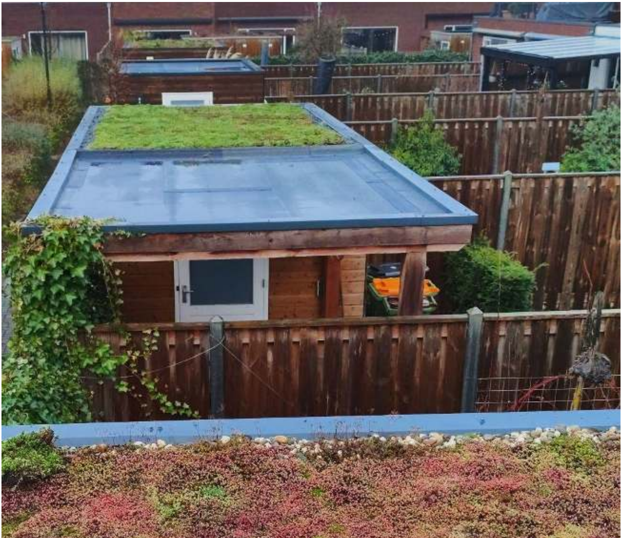
De stichting heeft bemiddeld in een subsidie van €12.000,- voor 94 groene daken met een totaal oppervlak van 1256m 2
